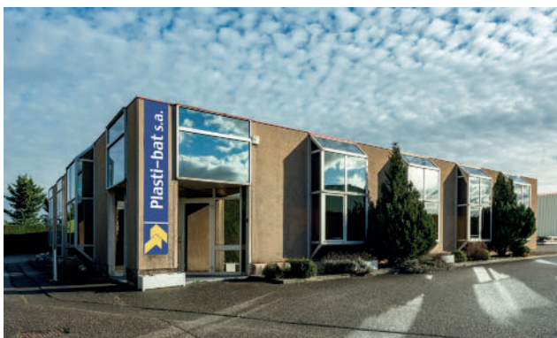
Plasti-Bat - Diemoz, France - Site commercial et logistique.
